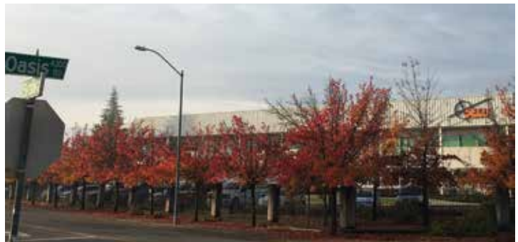
Las instalaciones de SECO en Redding estuvieron amenazadas por los fuegos incontrolados que tuvieron lugar en California en el 2018. No obstante, salimos adelante gracias al apoyo y generosidad de los que nos ayudaron durante el cierre temporal.
